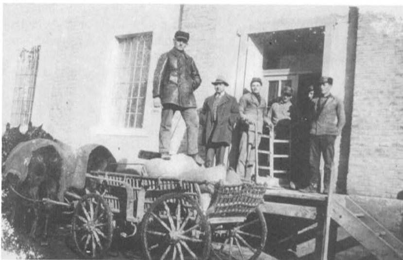
Aufnahme vor der neuen Mühle 1936
