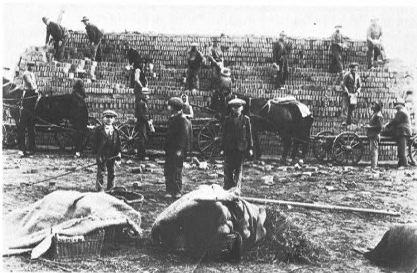
Setzen eines Ziegelbrennofens bei den sogenannten Ziegellöchern (um 1937).
