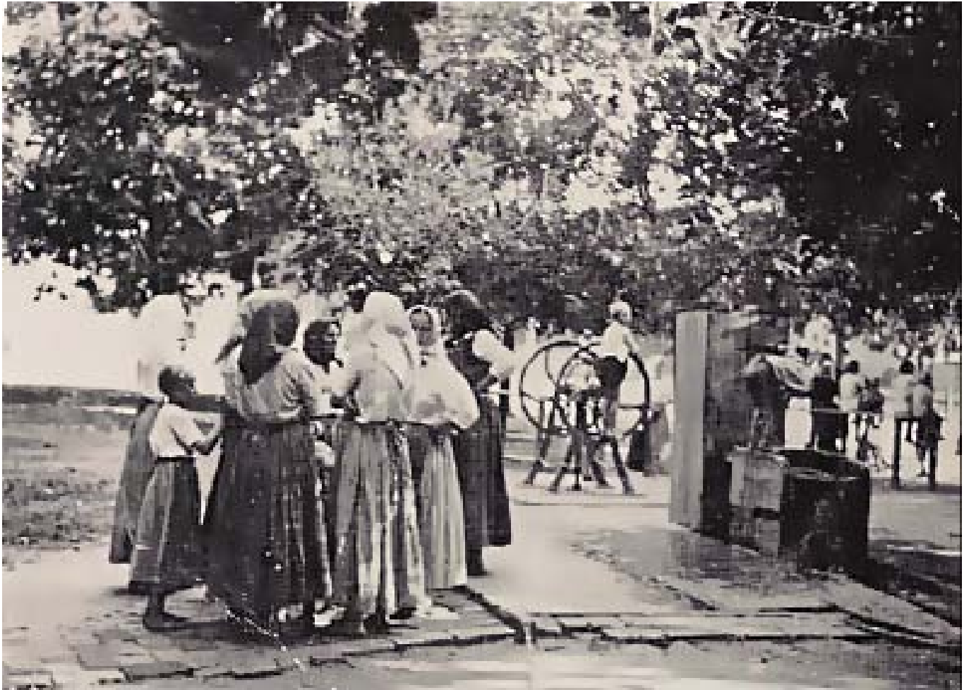
Beim Tiefbrunnen vor dem Park in Franzfeld.
